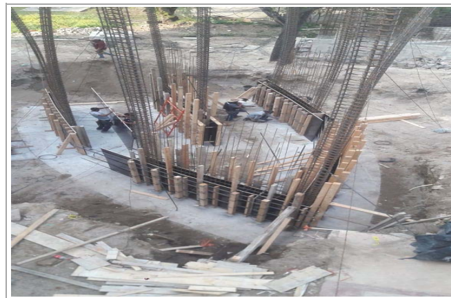
F4: Cimbra en muro MC- Cimentación
