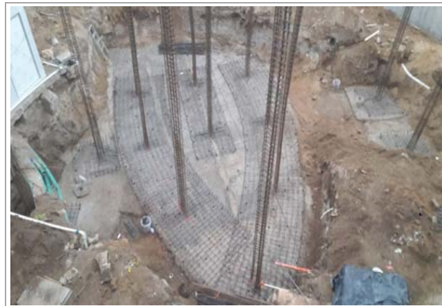
F1: Suministro, habilitado y armado de acero de refuerzo en cimentación
