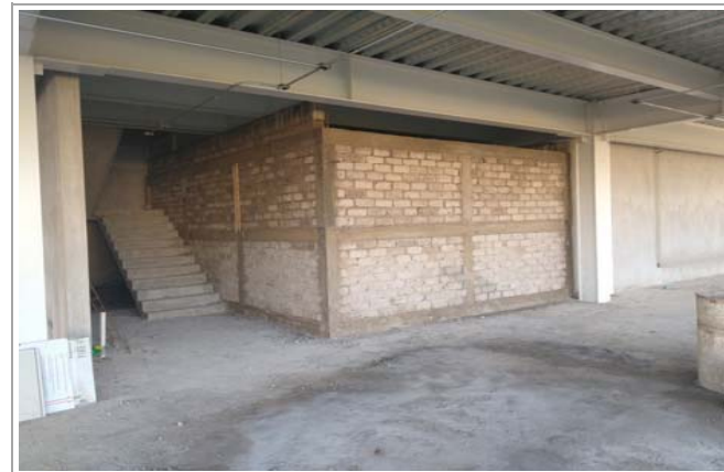
F4: Construcción de módulo de baños
