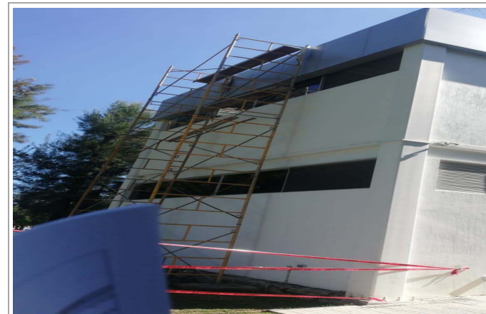
F2: Fachada posterior (instalación de andamios)
