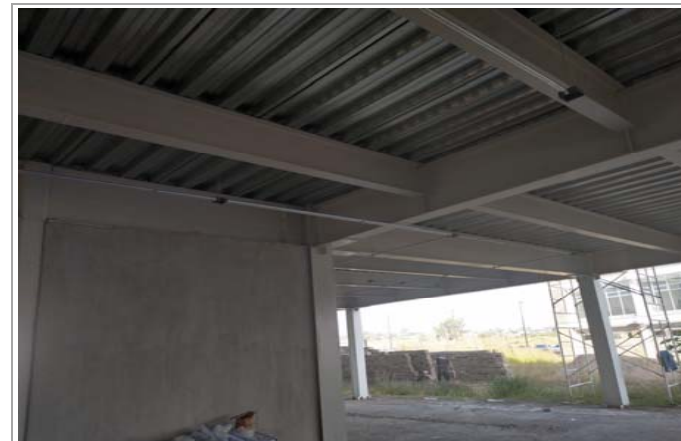
F2: Colocación de ductería eléctrica
