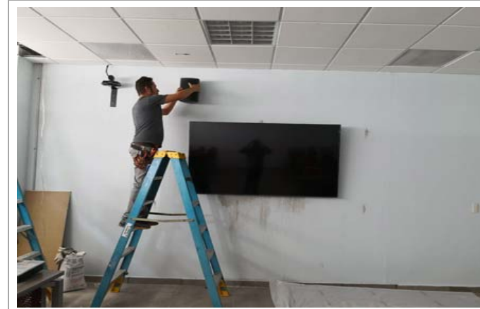
F2: Instalación de equipo
