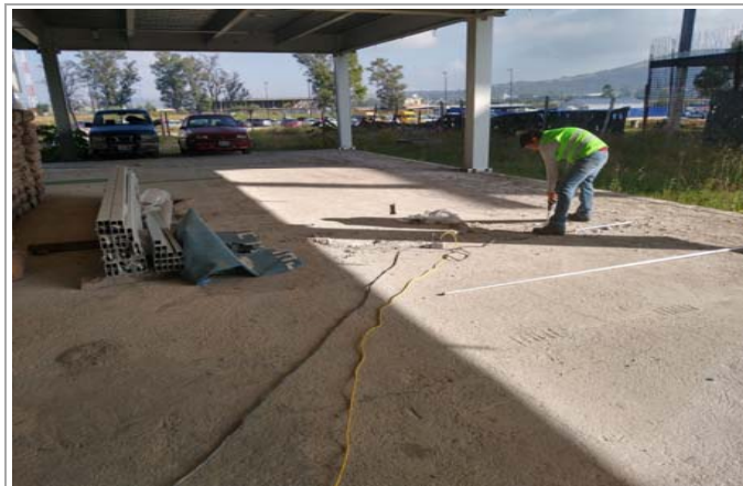
F1: Colocación de ductos eléctricos
