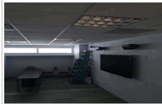
F4: Instalación de equipo
