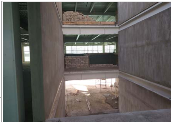
F3: Construcción de módulo de baños en planta baja y primer nivel
