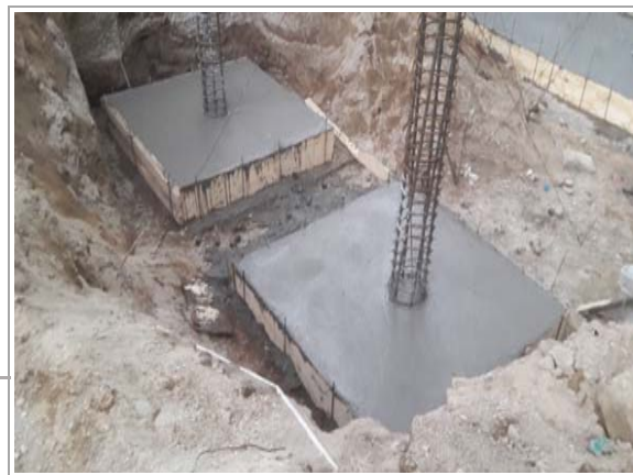
F3: Concreto en zapatas aisladas en cimentación
