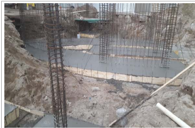
F2: Concreto en zapata corrida - Cimentación
