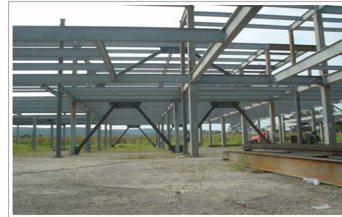
F5: Interior de aula
