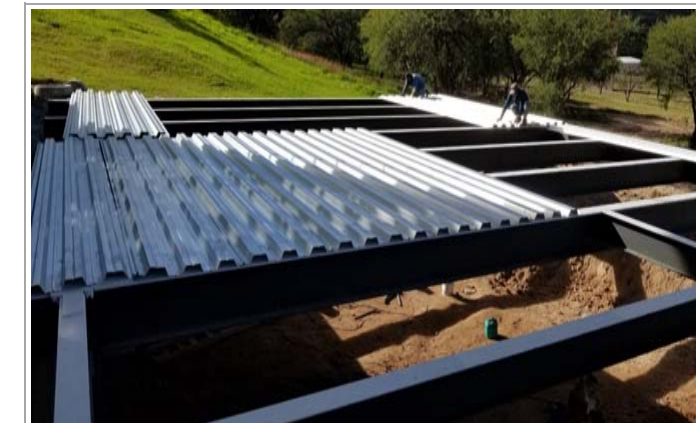
F5: Lámina losacero
