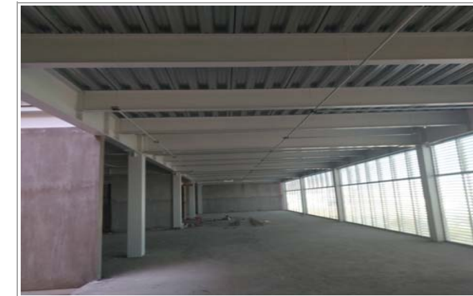
F5: Colocación de ductería para luminaria
