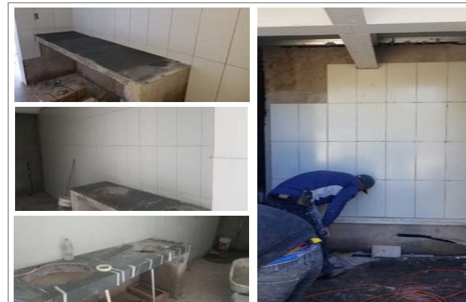
F2: Módulo de Baños
