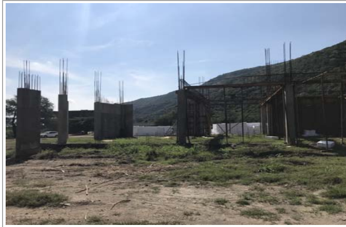
F1: Fachada principal
